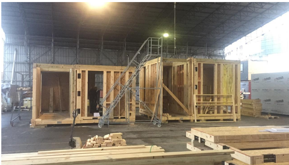
Fotografía 3: Pisos 1 y 2 montados.
