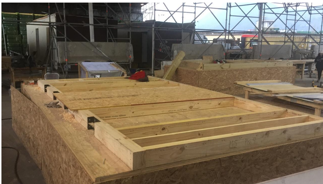
Fotografía 1: Fabricación de entramados de muros.
