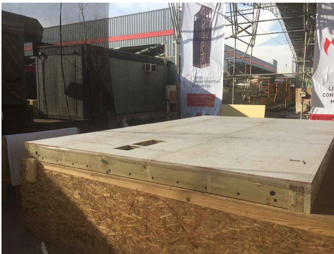
Fotografía 2: Fabricación de entramado de losas
