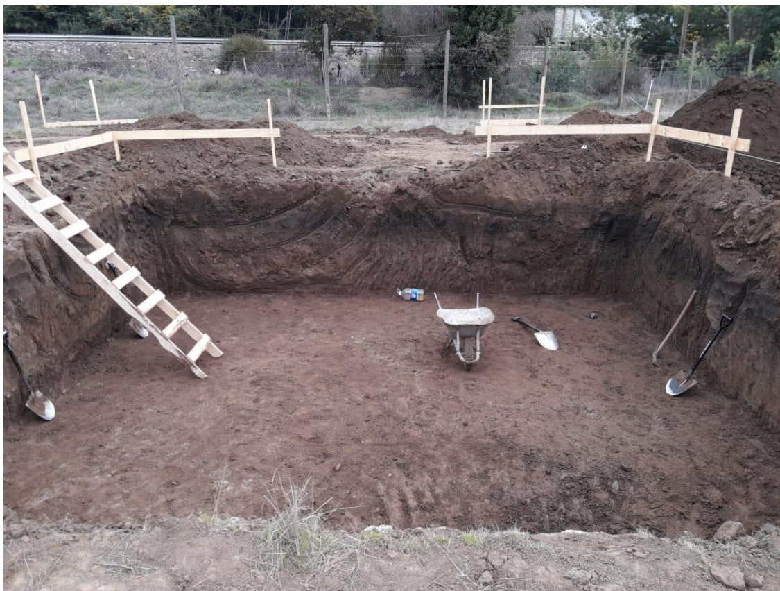
Fotografía 5: Sello de fundación de edificio principal.
