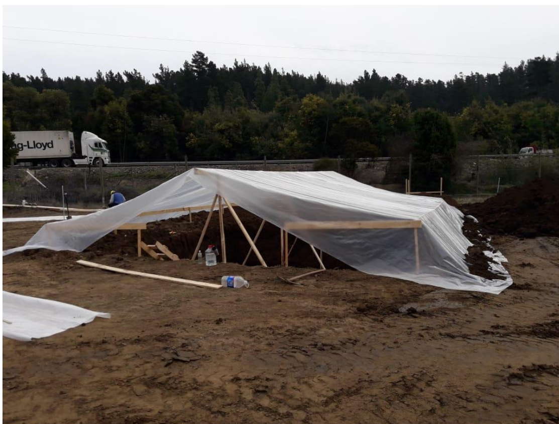
Fotografía 4: Excavación en proceso, cubierta por mal clima.
